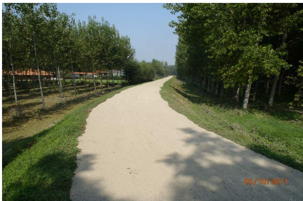
(foto n.01 – argine della Riservetta)
