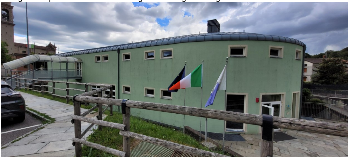
Figura 1 - Scuola primaria - lato nord
