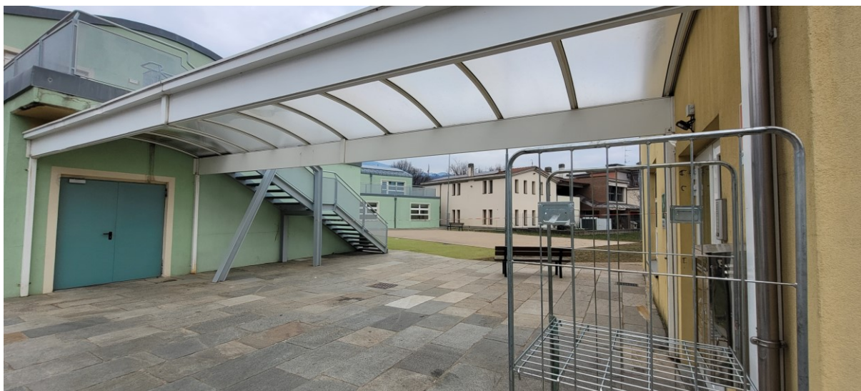
Figura 3 - Collegamento scuola primaria – edificio sud
