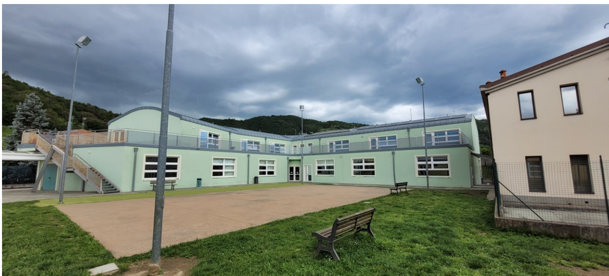
Figura 5 - scuola primaria – vista sud est
