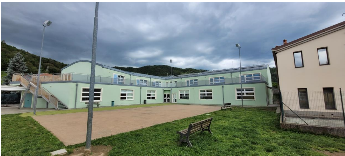
Figura 8 - scuola primaria corpo A – vista sud est
