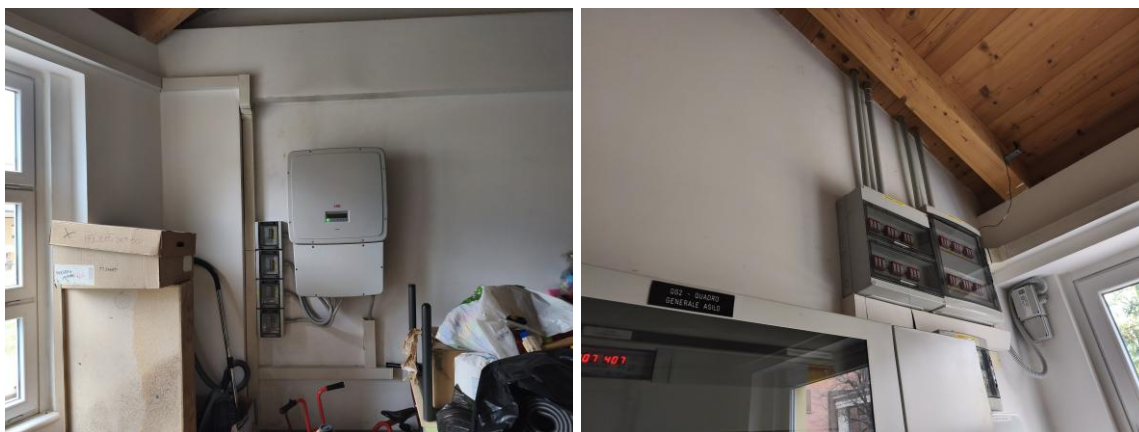
Figura 3 – Componenti dell'impianto fotovoltaico interno al copro B – sala insegnanti
