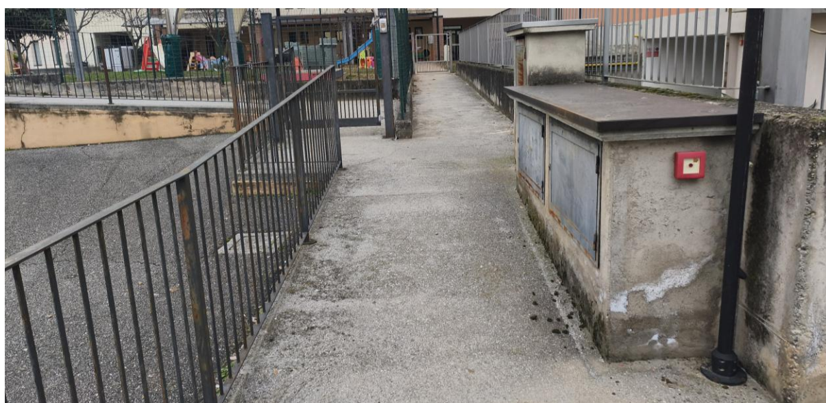
Figura 5 -ingresso pedonale scuola dell'infanzia corpo B e nicchia contatore
