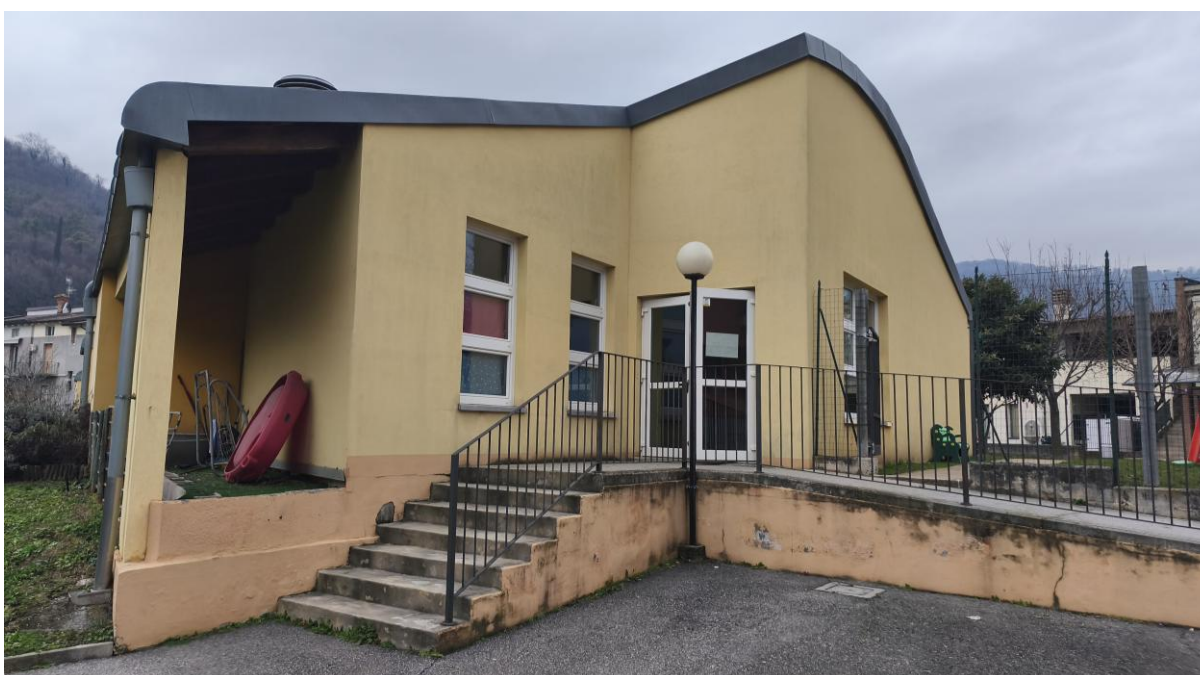
Figura 7 -ingresso pedonale scuola dell'infanzia corpo B
