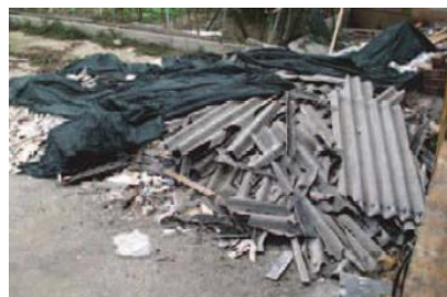
Deposito non corretto
