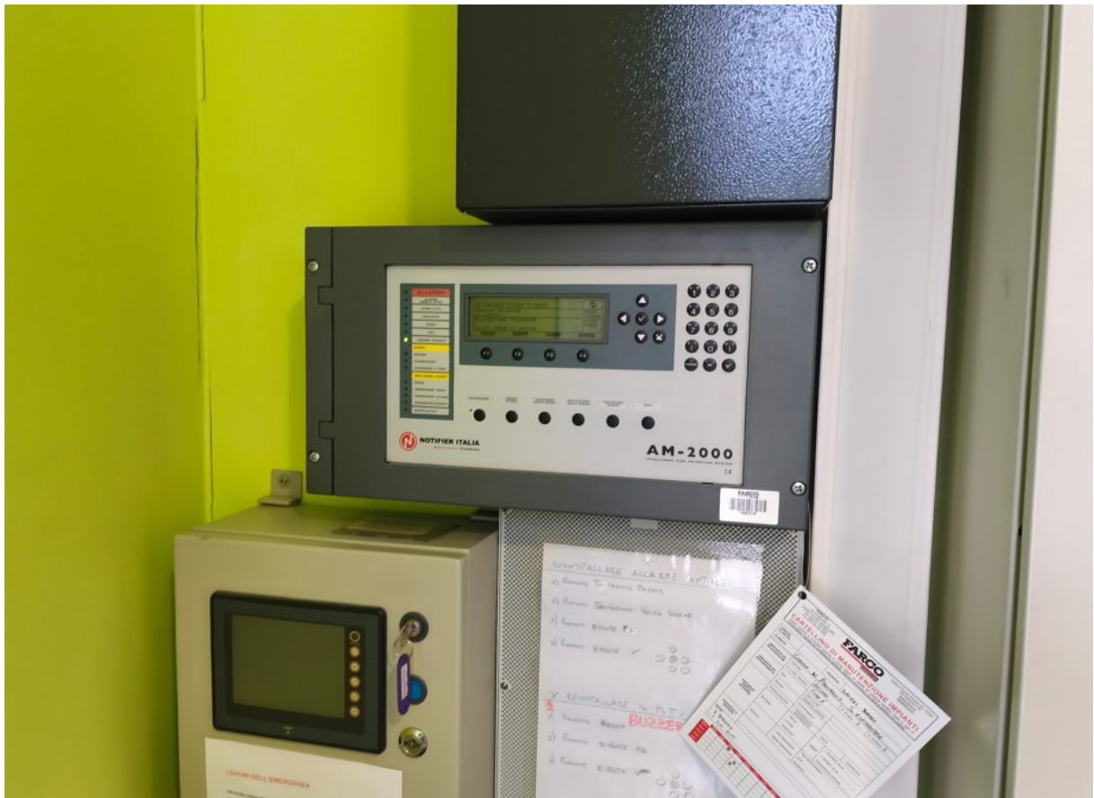
Figura 2-centrale IRAI scuola primaria - corpo A
