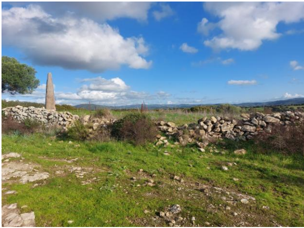
Esempi della muratura perimetrale "a secco" in stato di degrado
