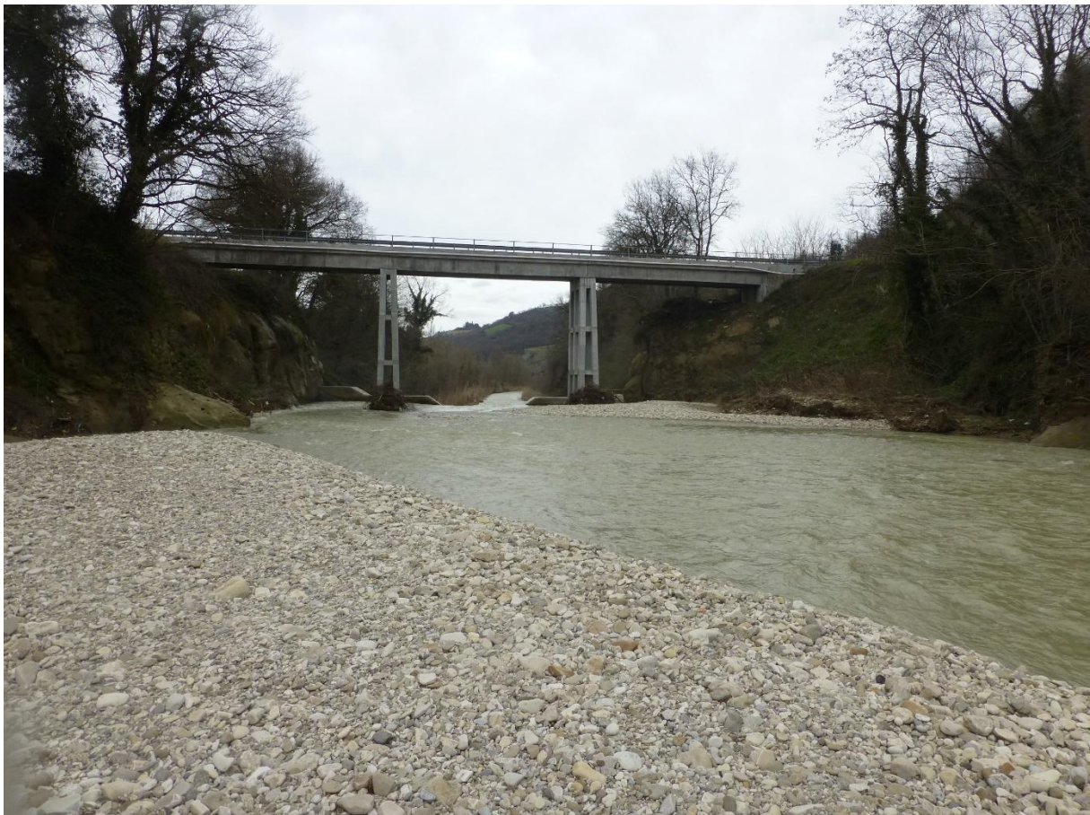
Foto 2.2 - Alveo del Fiume Foglia a monte della briglia
