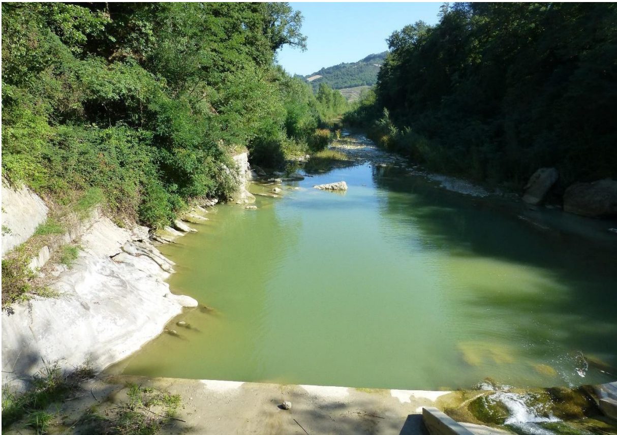
Foto 2.1 - Alveo del Fiume Foglia a valle della briglia sul ponte della Strada Provinciale di Paganica
