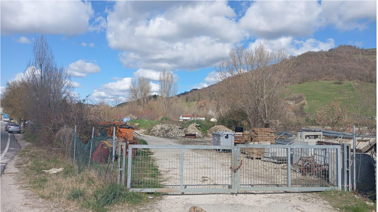
Foto 4.1 – Sito di proprietà dell'amministrazione comunale per lo stoccaggio di macerie edili
