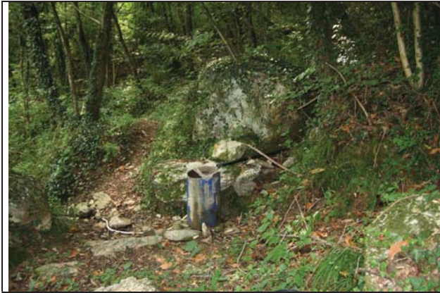
"Fontani de Mes" sulla mulattiera di mezzo q. m 415 P ≈ 0,1 l/s (captazione privata provvisoria)
