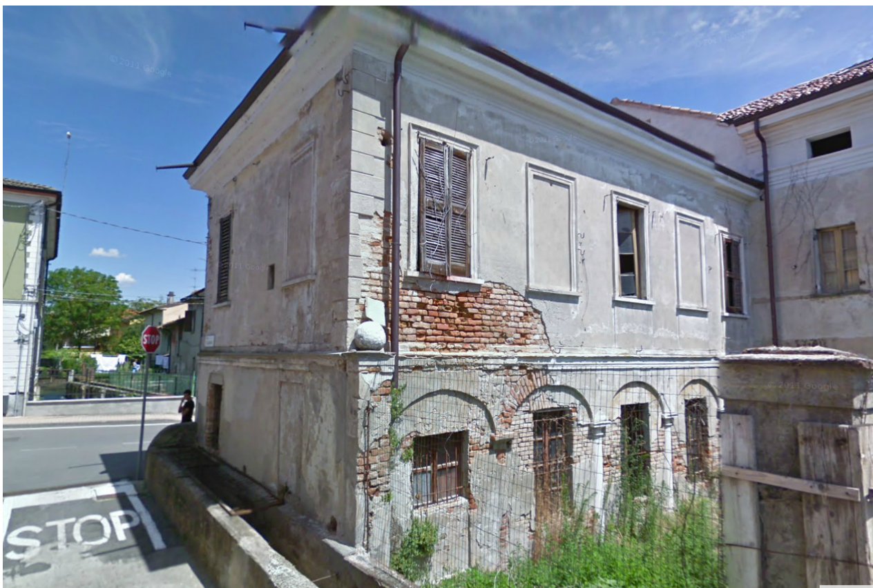
Figura 2 – Vista dell’immobile – vista da sud-ovest – la nord.
