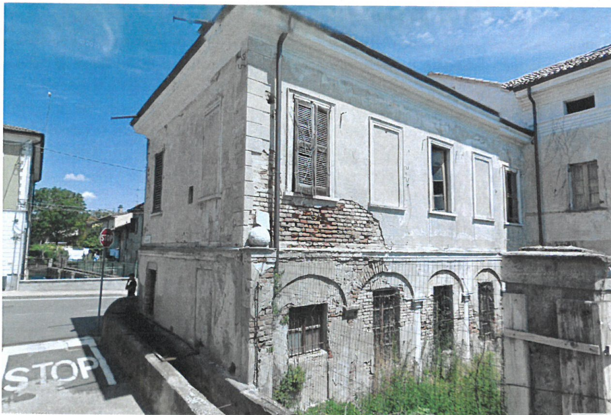
Figura 2 – Vista dell’immobile – vista da sud-ovest – la nord.
