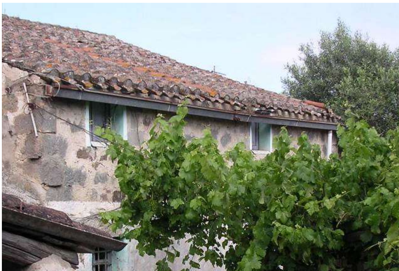
Esempio di soluzione di gronda con canale di raccolta delle acque
