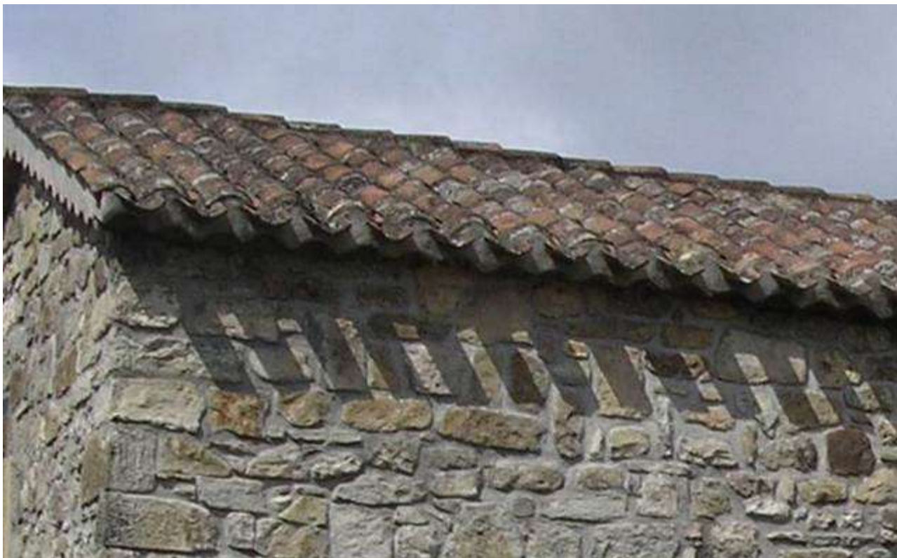
Esempio di soluzione di gronda senza canale di raccolta delle acque
