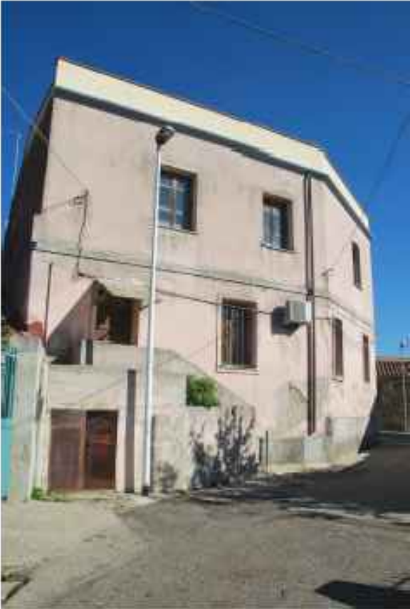
Prospetto laterale prima dell'intervento
