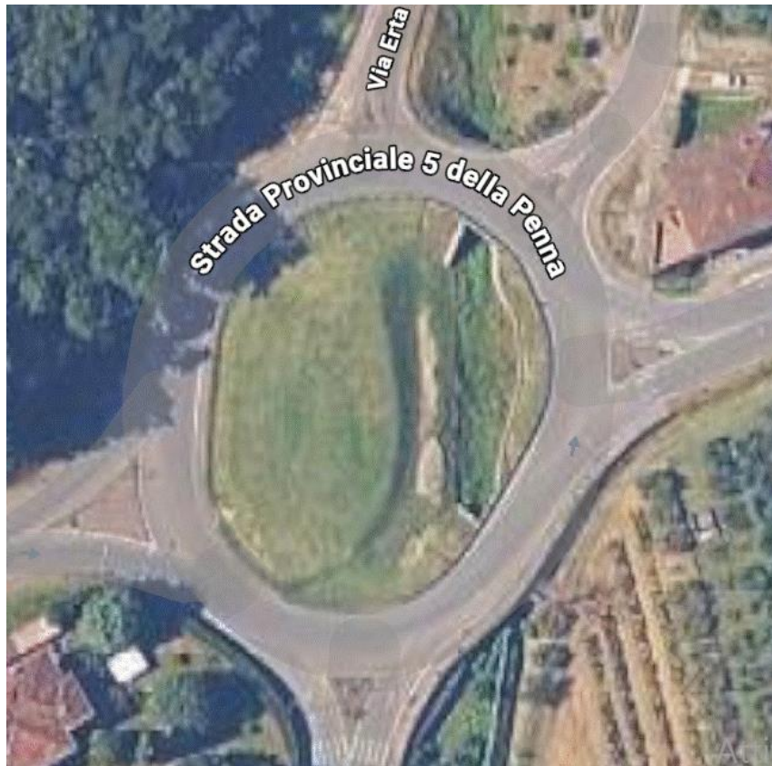
6- Rotatoria accesso all'abitato della frazione della Penna a monte dello stesso
