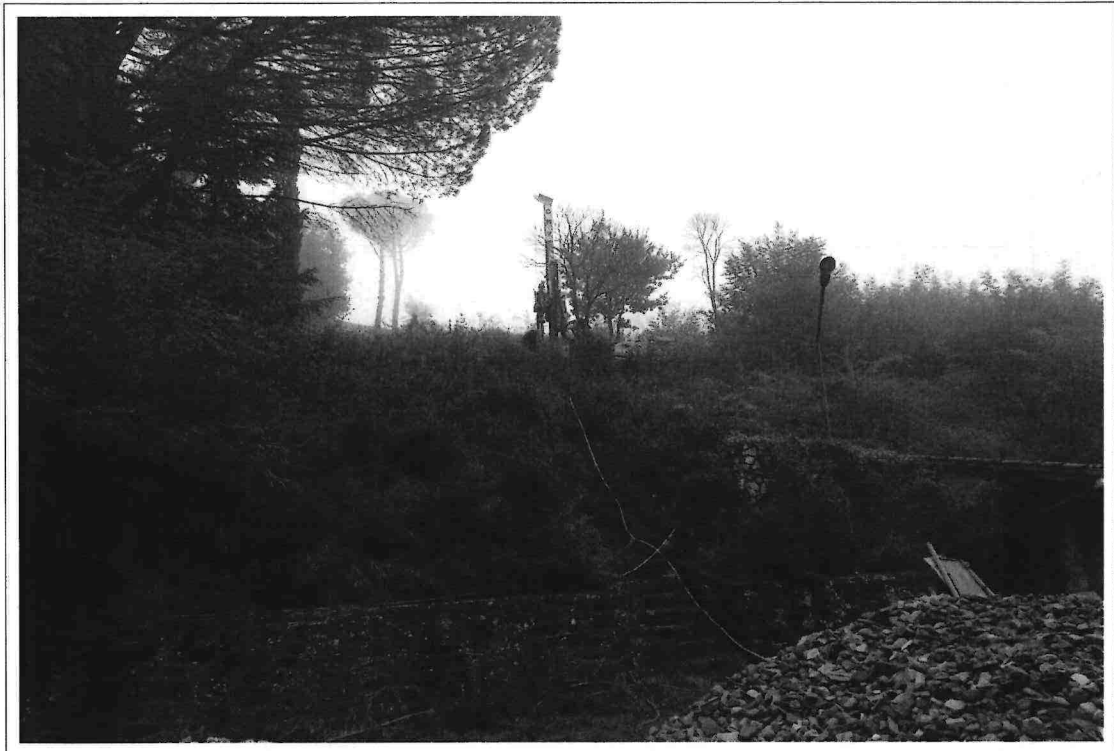
-Posizionamento della macchina operatrice nel Sondaggio S1
