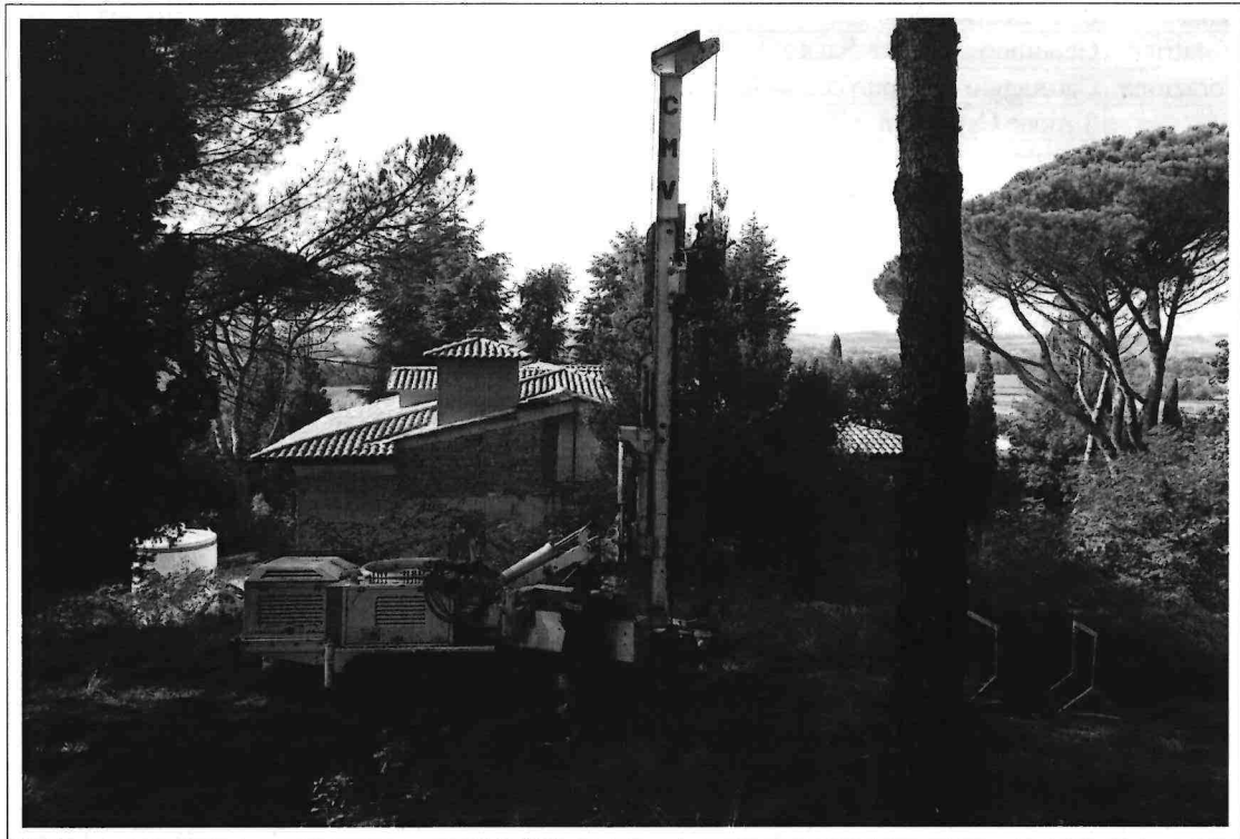
-Posizionamento della macchina operatrice nel Sondaggio S2
