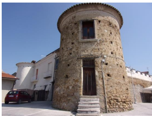
Fig. 32, particolare della torre circolare del lato sud – est,
