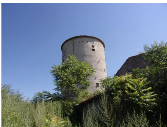
Fig. 86, la torre Marruocchi oggi, vista da sud
