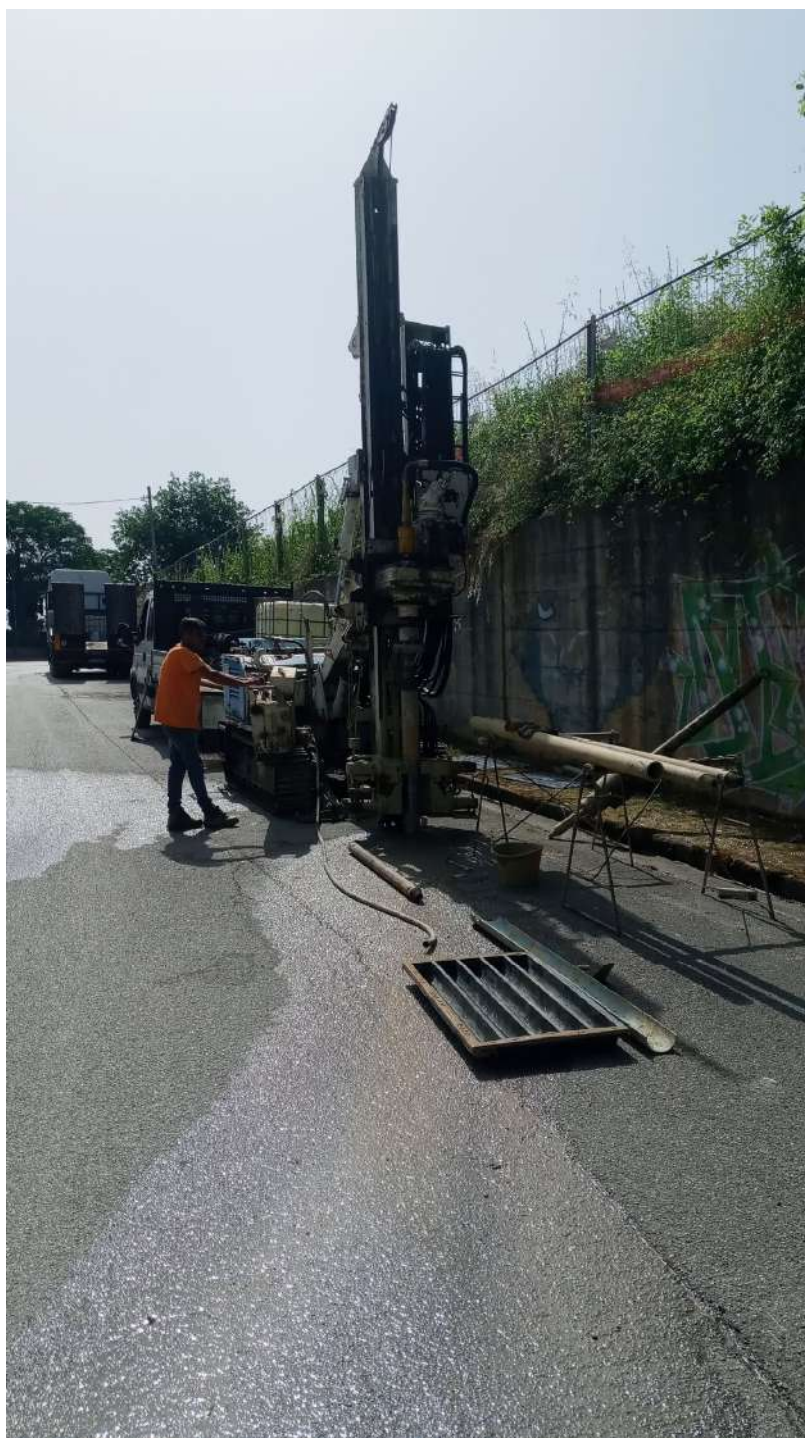
Postazione ed esecuzione sondaggio S2.
