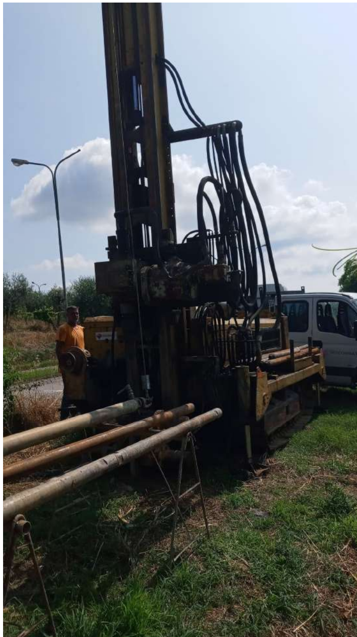
Postazione ed esecuzione sondaggio S4.
