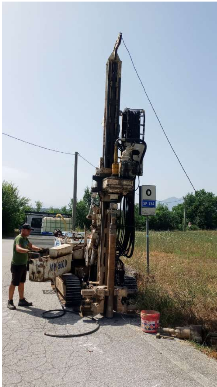
Postazione ed esecuzione sondaggio S6.
