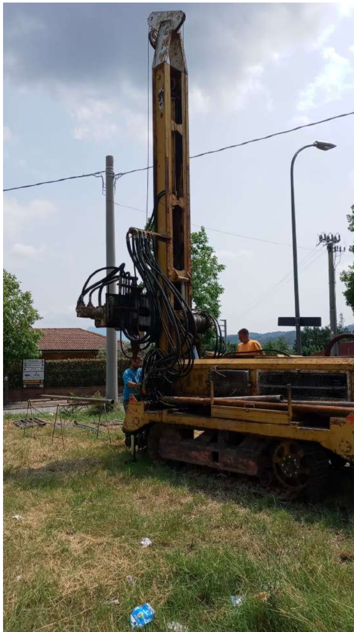
Postazione ed esecuzione sondaggio S5.
