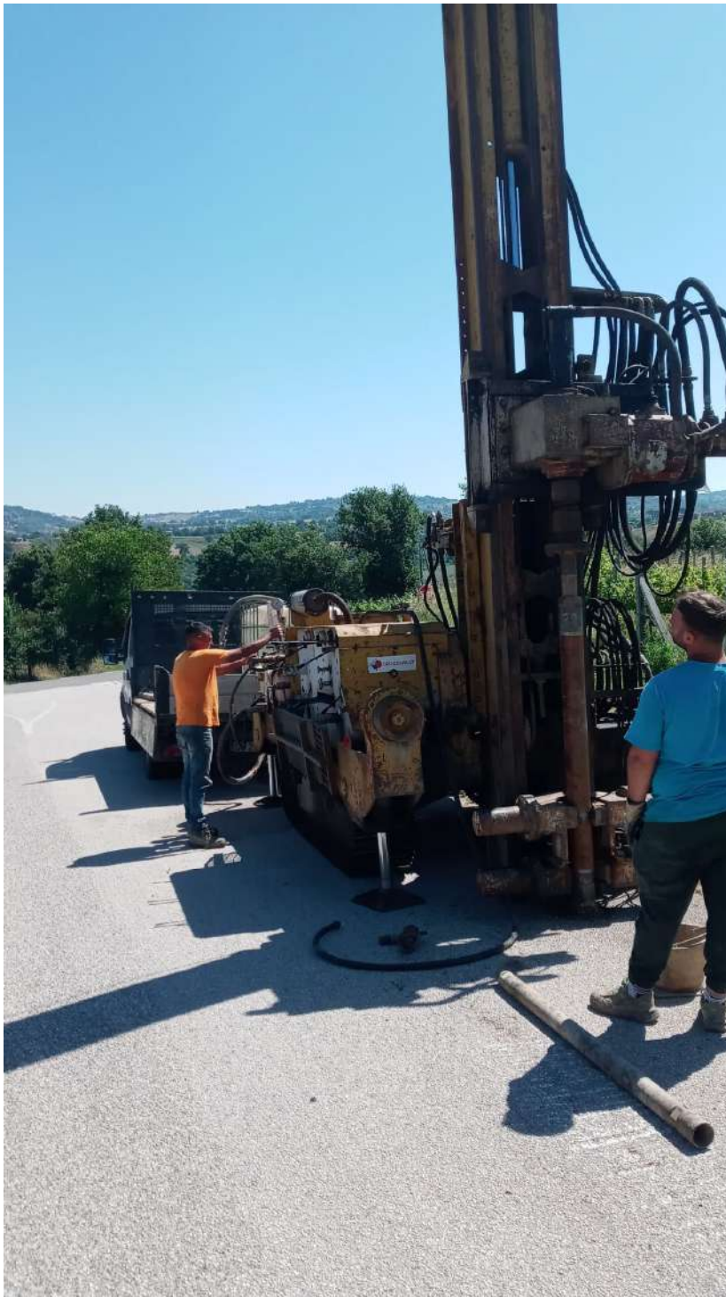
Postazione ed esecuzione sondaggio S3.
