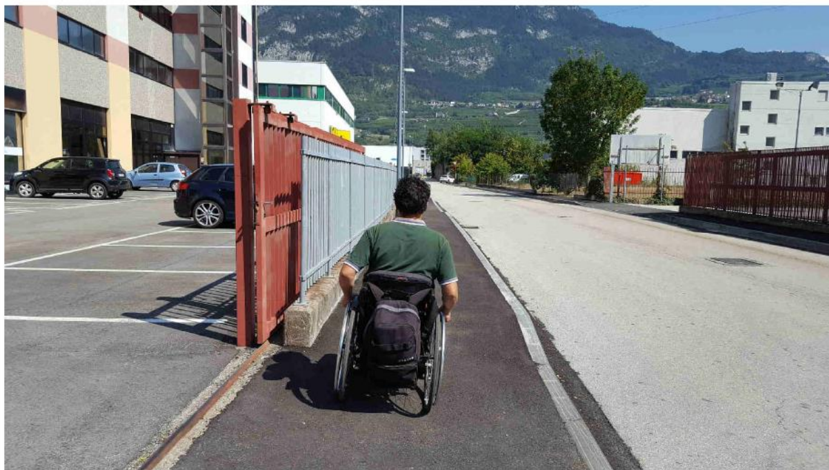
Raccordo accesso carralo errato pendenza trasversale >1.00%
