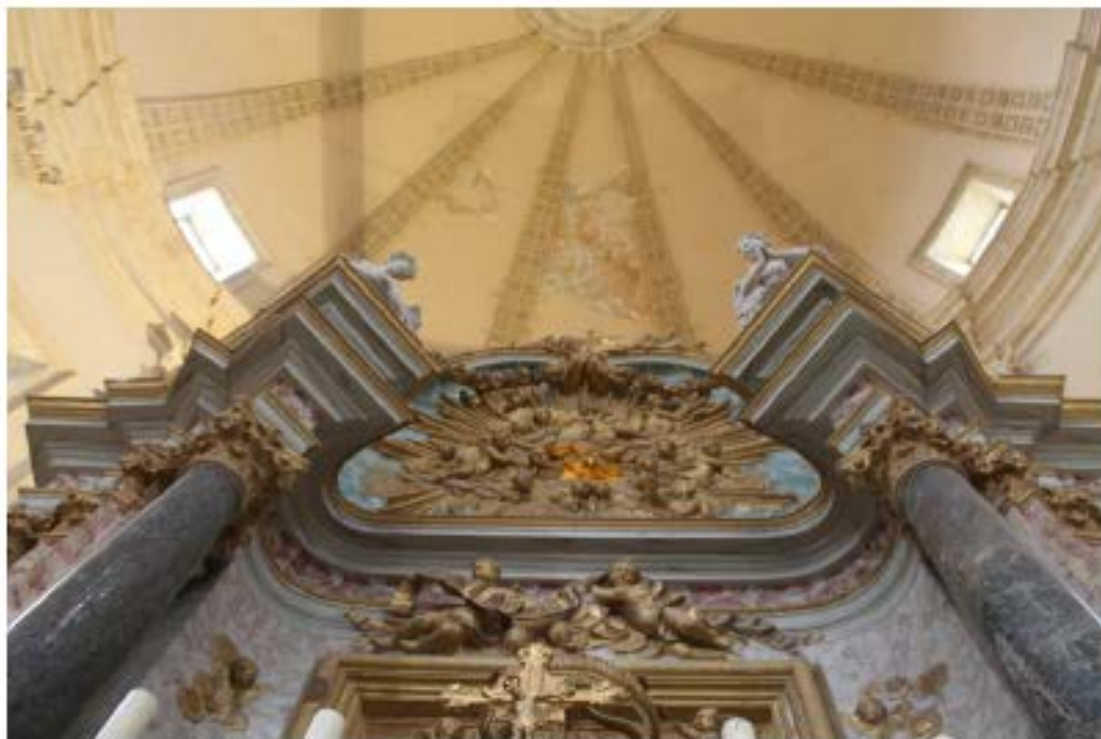
Fig. 16 - Vista dal basso che evidenzia l'andamento concavo della parete e trabeazione soprastante
