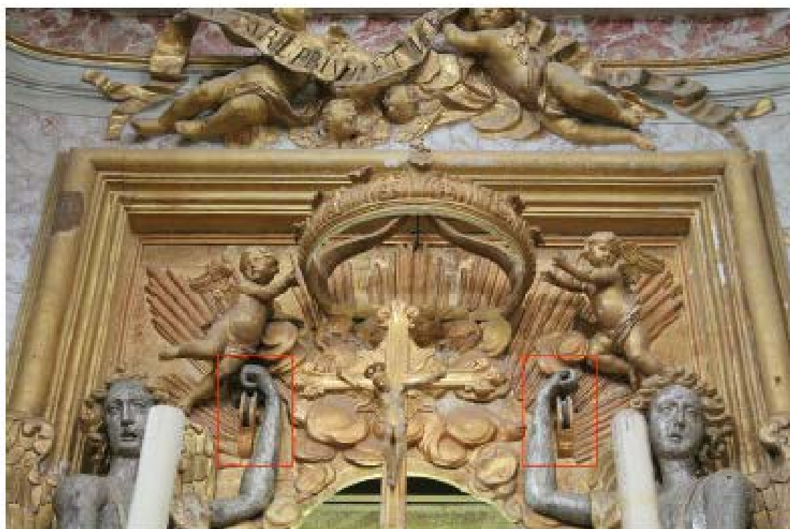
Fig. 27 - Dettaglio delle due carucole che raccoglievano le corde in uscita dal catiglio, passanti attraverso le mani dei due angeli
