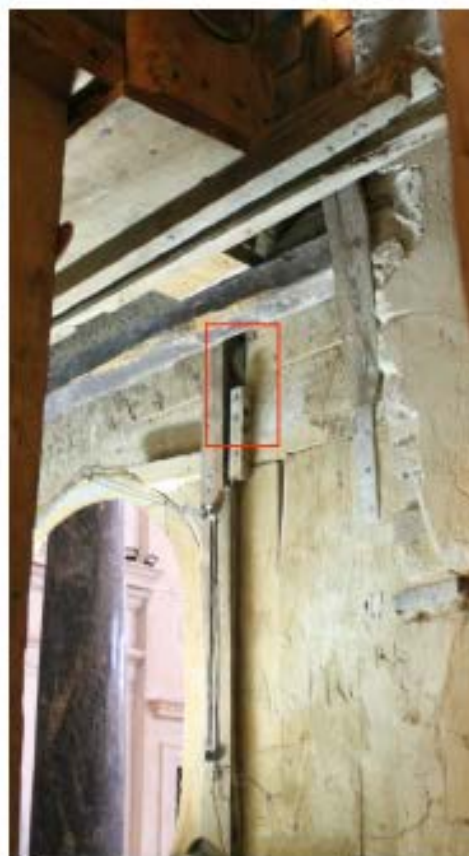
Fig. 25 - Dettaglio di una delle due carrucole inserite nel cartoccio ligneo
