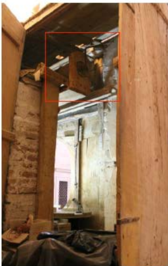
Fig. 24 - Intercapedine tra il cartoccio e l'immagine. Da notare l'argano posto sulla parte alta del vano
