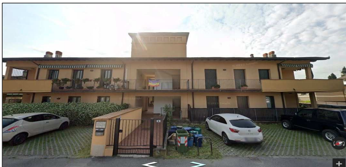
Vista Ovest dell'immobile (Fonte: Google Street-View)
