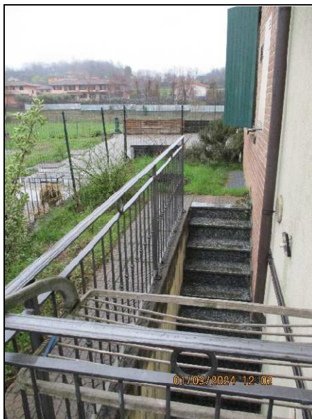
Scala esterna di collegamento con il box auto (subalterno 42)
