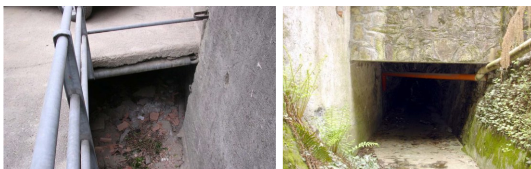
Foto Valleggio di Là , attraversamenti stradali di via Torretta e Via Palazzi – tratto intubato a monte di abitazioni private (Fonte Studio RIM)
