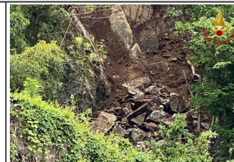
Frana a monte di SS394/Galleria Colmegna – 2021 -VVF
