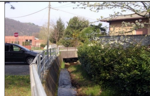
Via Copelli – Gorizia – torr. Maina
