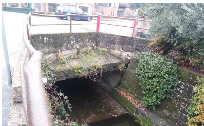
Foto – sx: ingresso tratto intubato torrente Luina. Dx. Ingresso tratto intubato roggia a monte del parcheggio del cimitero
