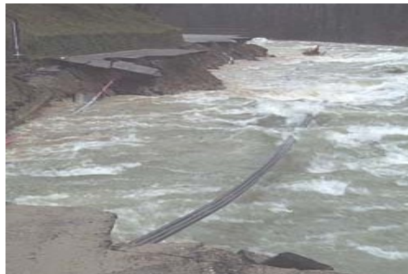
Foto – Frana di Cremenaga e crollo della Sp61 in seguito all'erosione della sponda per opera del fiume Tresa in piena – maggio-novembre 2002
