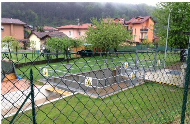
Foto: Canale scolmatore e Vasca Volano poste in località Premaggio (Germignaga e Luino) al fine di contenere le portate del fosso Mondiscia
