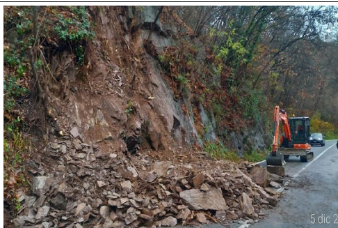
Disgaggi lungo SS344dir – 2022 - fonte:Luinontizie
