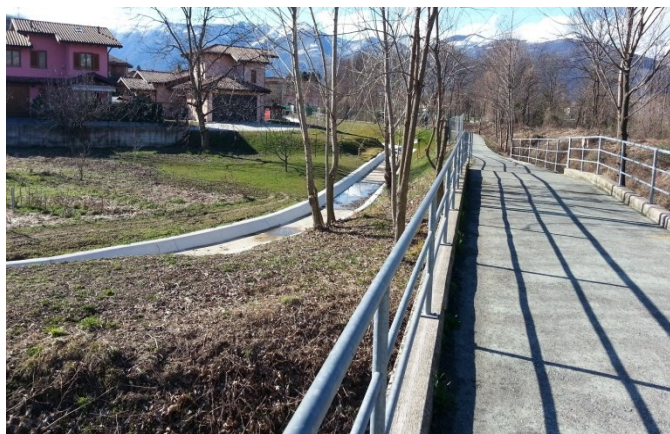
Foto: Canale scolmatore e Vasca Volano poste in località Premaggio (Germignaga e Luino) al fine di contenere le portate del fosso Mondiscia
