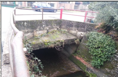
Torrente Luina ingresso tratto intubato
