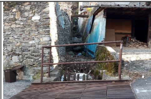
Valleggio Colmegna – ingresso tratto intubato
