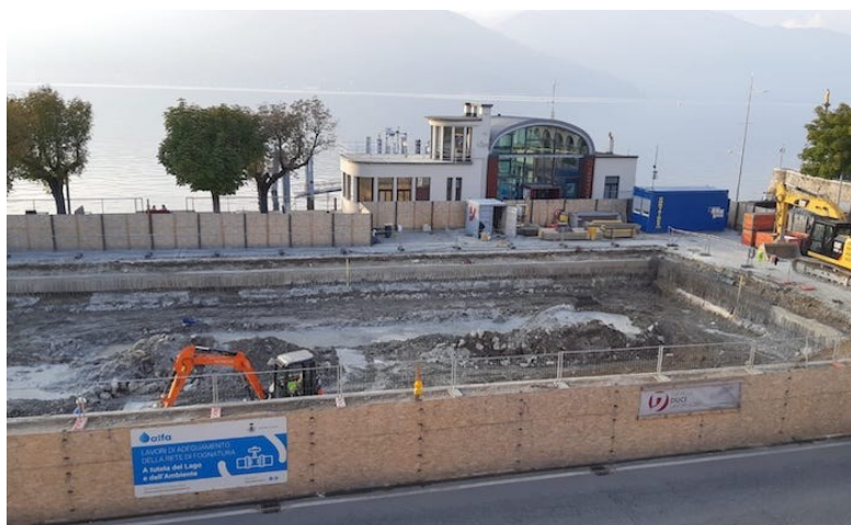
Vasca di prima pioggia in p.za. Libertà a Luino progettata ed eseguita da Alfa Srl – fonte Luinonotizie.
