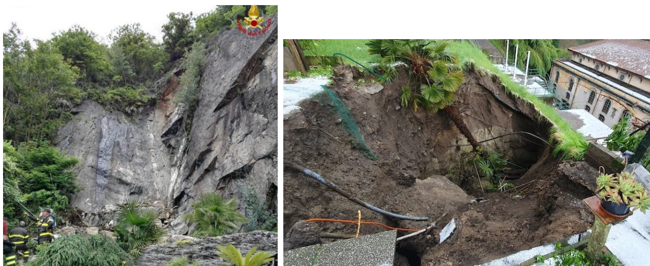
Foto: Frana a monte di via Creva. Distacco del 06/2016 fonte VVF Dx. Frana a monte dele centrale di Creva – 2024 fonte: Luinontizie
