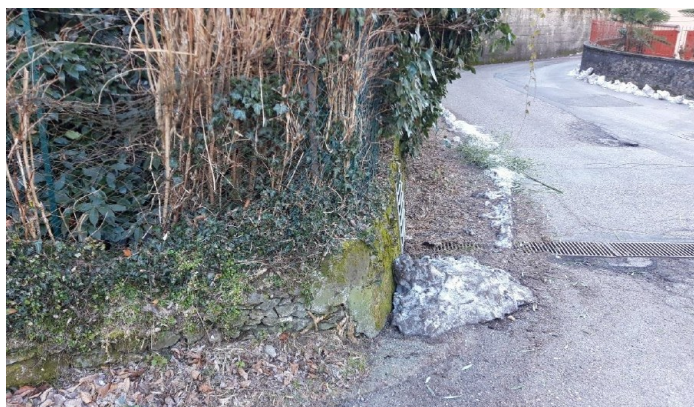
Foto tratto intubato torrente via Carnella (Fonte Studio RIM)
