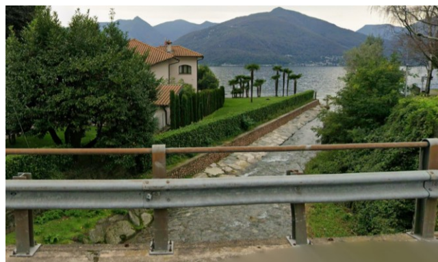
Foto: foce del torrente Colmegno. Abitazione presente in sponda idrografica sinistra a ridosso dell'alveo.
