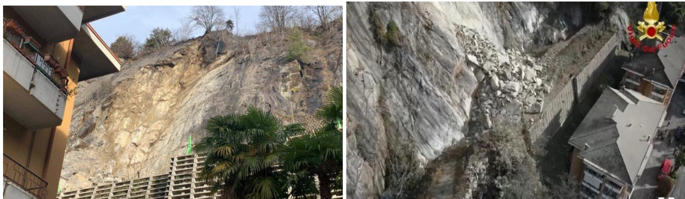
Foto: Frana a monte di via Creva. Sx. distacco del gennaio 2023 fonte VVF che portò all'evacuazione di 11 famiglie
