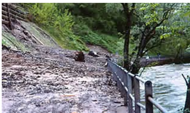
Foto – Frana di Cremenaga e crollo della Sp61 in seguito all'erosione della sponda per opera del fiume Tresa in piena – maggio-novembre 2002
