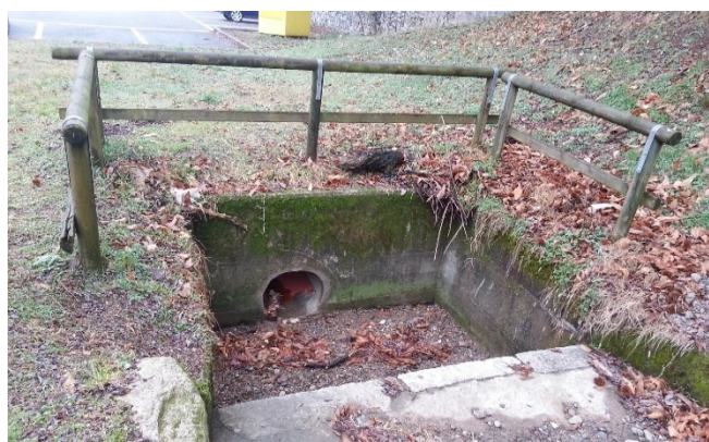
Foto – sx: ingresso tratto intubato torrente Luina. Dx. Ingresso tratto intubato roggia a monte del parcheggio del cimitero
