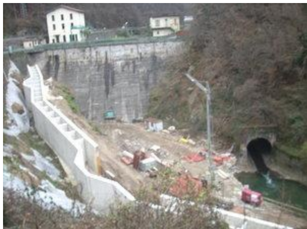
Foto - Sx. Diga di Creva vista da valle si noti il nuovo corridoio realizzato per consentire la migrazione dei pesci– fonte corriere del Verbano Dx. Invaso di Creva svuotato, - fonte http://www.ilblogdellapesca.it/
