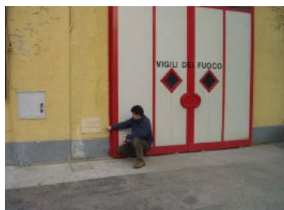
Foto – Caserma dei Vigili del Fuoco - E' indicata la tacca relativa al livello raggiunto (+ 63 cm dalla quota terra) dalle acque del Tresa in occasione dell'evento alluvionale dell'ottobre 1993 – fonte CNR-IRPI
