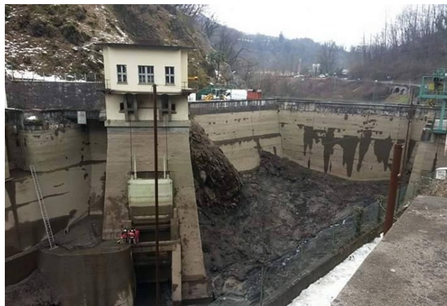
Foto - Sx. Diga di Creva vista da valle si noti il nuovo corridoio realizzato per consentire la migrazione dei pesci– fonte corriere del Verbano Dx. Invaso di Creva svuotato, - fonte http://www.ilblogdellapesca.it/
