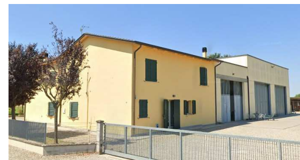
Edificio residenziale con annesso ricovero per mezzi agricoli
