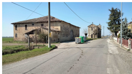
Edificio agricolo in cattivo stato di conservazione
