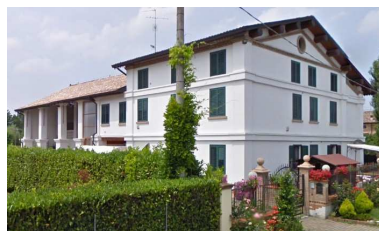
Edificio agricolo recuperato ad uso residenziali
