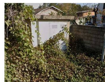
Manufatto tecnico (T)
