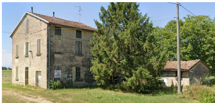
Edifici agricoli collabenti
