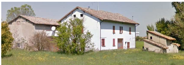
Edificio agricolo semi-abbandonato
