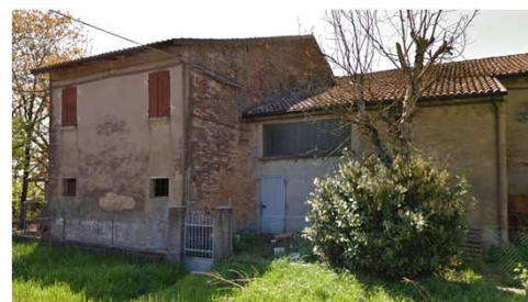
Edificio agricolo semi-abbandonato
