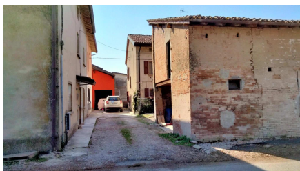
Fabbricati nel lato sud della frazione
