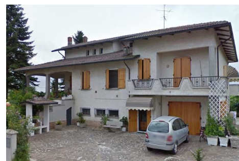
Edificio residenziale bifamiliare
