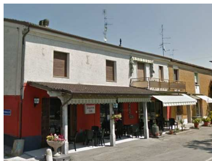
Edifici ad uso residenziale al piano primo e commerciale al piano terra
