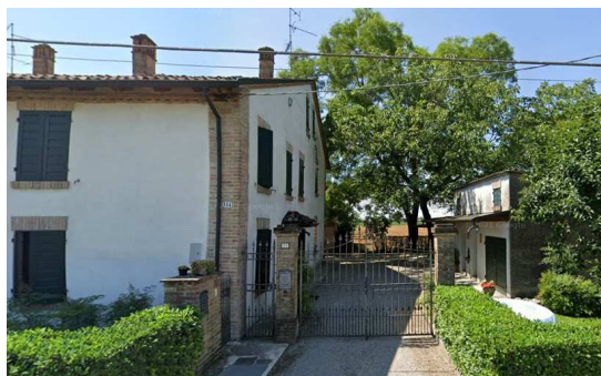
Fabbricato agricolo recuperato ad uso residenziale
