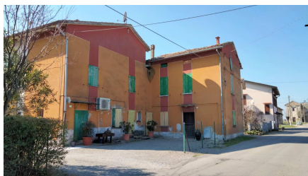
Fabbricati nel lato sud della frazione
