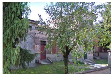
Edificio antico di pregevole e particolare fattura una volta adibito ad uso scolastico
