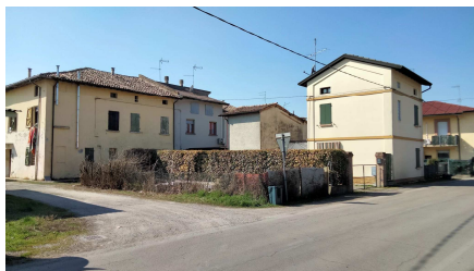
Fabbricati nel lato sud della frazione
