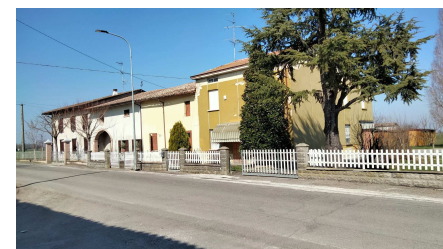
Fabbricati nel lato nord-ovest della frazione
