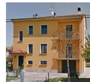
Edificio residenziale mono-bifamiliare
