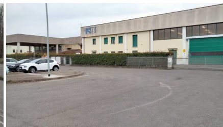
Edifici produttivi recenti in via Da Vinci
