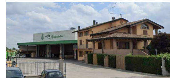
Edificio artigianale-produttivo con annessa residenza
