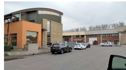
Edifici produttivi anni 70 e recenti in via G. Galilei
