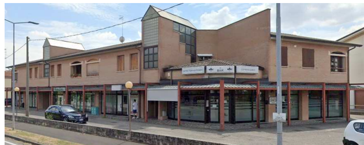
Edificio ad uso misto residenziale commerciale
