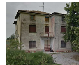
Fabbricato residenziale in cattivo stato di conservazione
