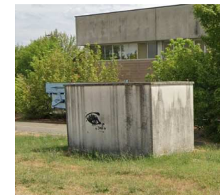
Impianto tecnologico (T)
