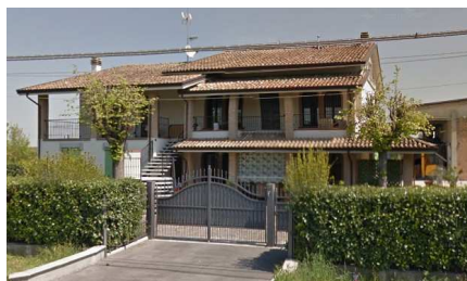
Edificio residenziale mono-bifamiliare
