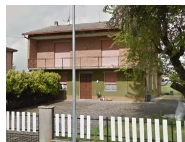
Fabbricato residenziale unifamiliare data
