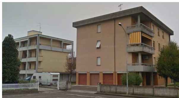
Edilizia residenziale in palazzine a 3-4 piani
