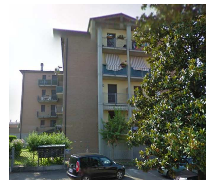
Edificio residenziale pluripiano
