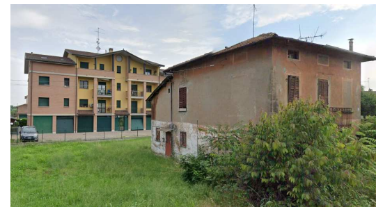
Fabbricato in stato di abbandono e sullo sfondo palazzina residenziale 3-4 piani
