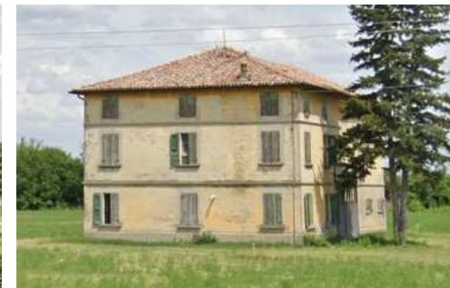
Edificio in stato di abbandono
