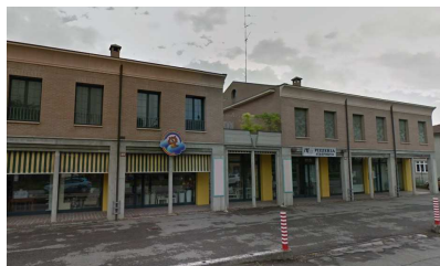
Fabbricato con PT ad uso commerciale
