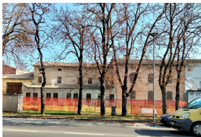
Centro storico da viale D. Alighieri
