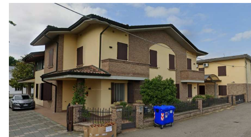
Edificio residenziale mono – bifamiliare
