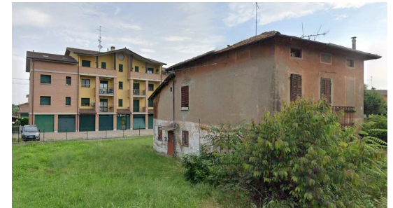
Fabbricato in stato di abbandono e sullo sfondo palazzina residenziale 3-4 piani
