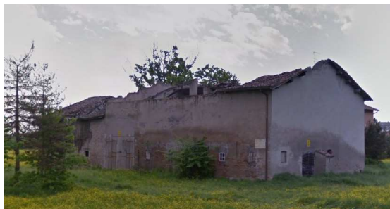
Fabbricato rurale collabente
