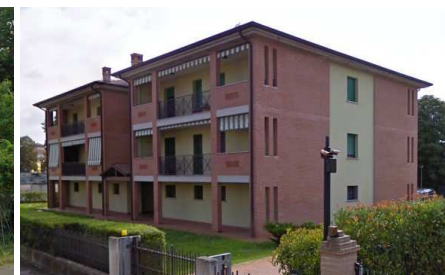
Edifici residenziali 3-4 piani
