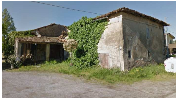
Edifici rurali collabenti
