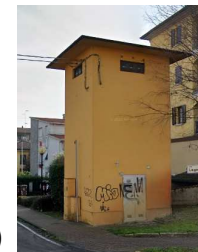
Impianto tecnologico (T)
