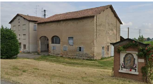
Edificio rurale con funzione residenziale
