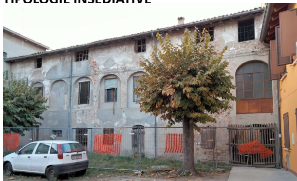
Corte interna da ristrutturare in via XX settembre – Piazza degli Orti
