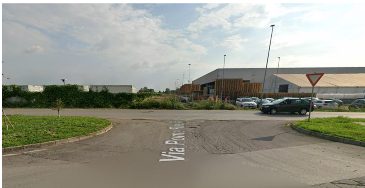
Foto 5 – Intersezione 2: vista da nord
