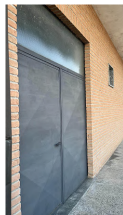
Magazzini, deposito rifiuti speciali
