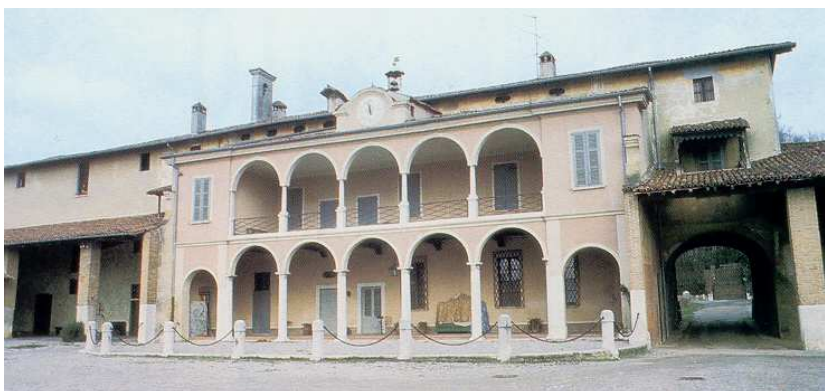
Fig.19 Casa padronale Calini all'interno della cascina Colombaie
