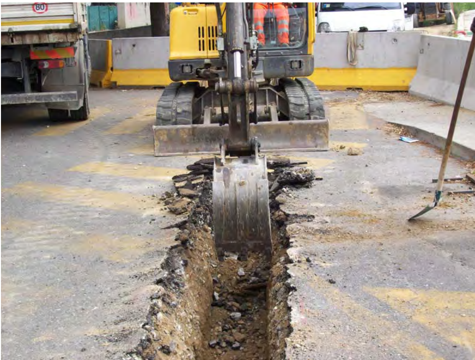
Esempio di trincea
