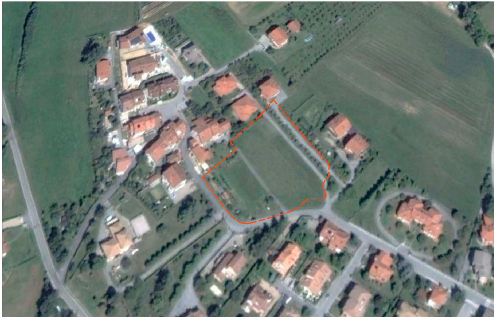
Vista aerea area oggetto d'intervento
