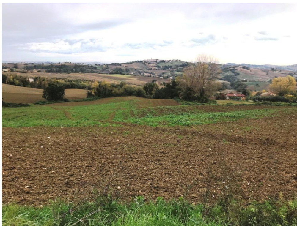
Foto n. 7 – Vista del versante in frana a Nord del Centro abitato di Torre S.Marco. Sono evidenti le ondulazioni dovute al movimento gravitativo.
