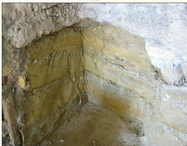
Foto 1 – Affioramento del Membro delle Arenarie di Borrello nell’ambito di alcuni lavori di ristrutturazione presso il centro abitato di Torre S.Marco lungo Via Borgo Torre. La foto mostra la stratificazione delle areniti del Membro delle Arenarie di Borello intercalate da peliti con inclusioni di bioclasti.
