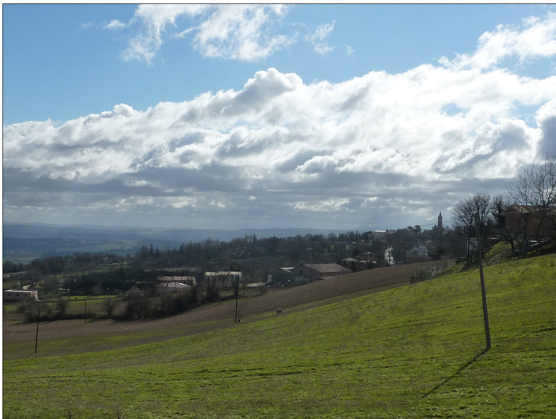
Figura 3.8 – Settore del fianco nord-orientale della cresta che conduce dalla Frazione Convento Santa Vittoria in direzione Fratte Rosa; si notano ondulazioni e contropendenze che attestano localmente la presenza di fenomeni di instabilità attivi (colamenti lenti superficiali).
