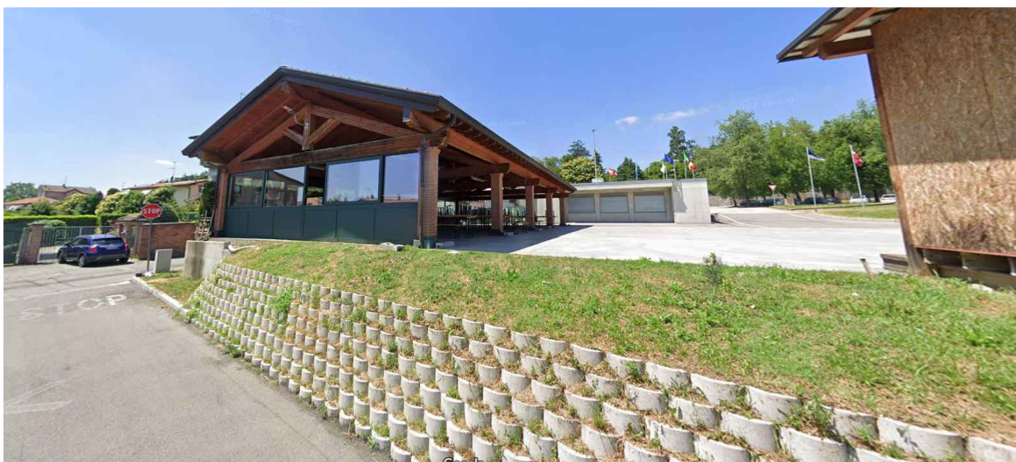
RILIEVO FOTOGRAFICO STATO DI FATTO
