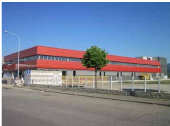
Figura 5: Immagine esterna del Datacenter
