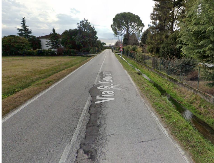
Figura 8: Via San Giovanni vista da nord
