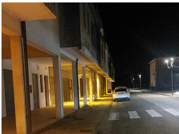
Figura 26 Tratto Via Gramsci, Matteotti, De Gasperi e 1°Maggio con apparecchi LED con zone di ombra
