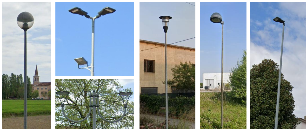
Figura 15 Varie tipologie di apparecchi illuminanti riscontrate durante i rilievi
