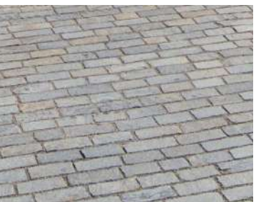
Pavimentazione in Luserna, posati a malta e boiacca o resina, per le parti carrabili e strade
