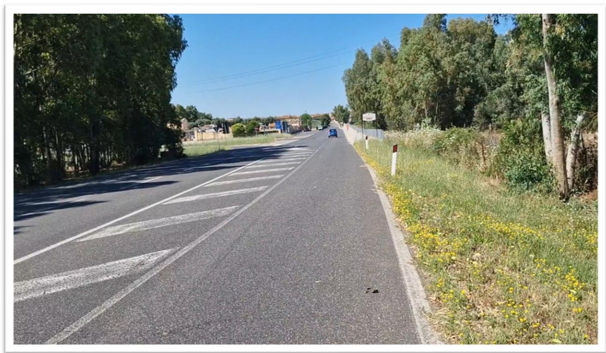
Figura 6: Ante intervento - Punto di scatto 1
