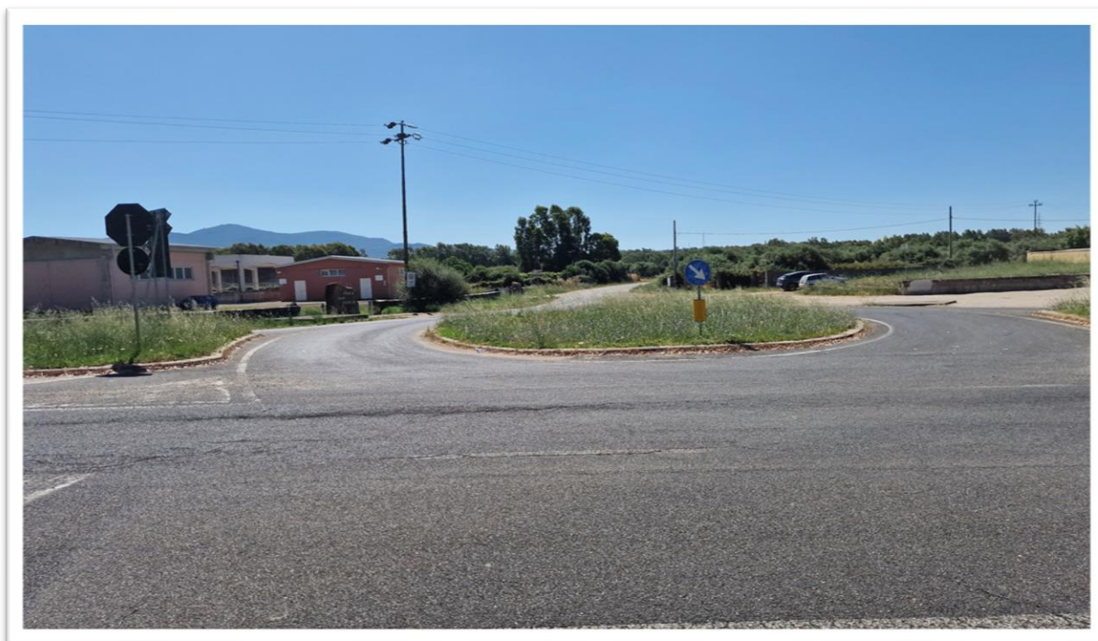
Figura 7: Ante intervento - Punto di scatto 2
