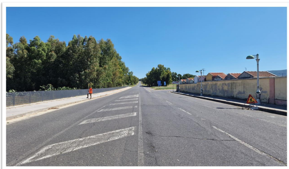
Figura 8: Ante intervento - Punto di scatto 3
