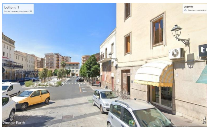
Prospetto su Piazza Garibaldi
