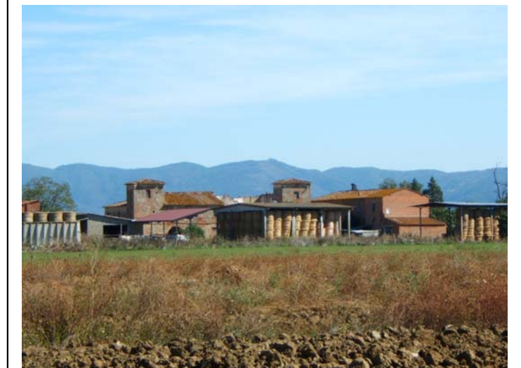
Vista verso gli edifici storici interni di Ponte a Ramo
