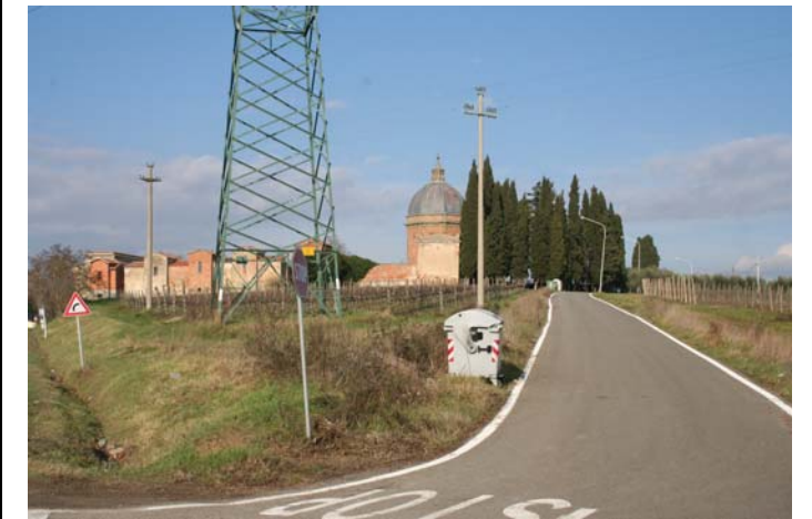
L'area del cimitero e del Tempio della Vittoria
