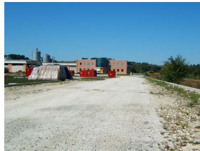
Vista del settore nord dell'area
