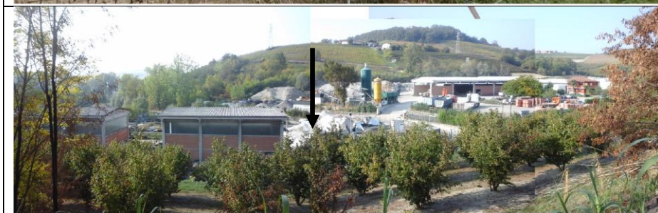
vista n. 2 dell'area dalla SP3 tratto immediatamente a monte dell'area
