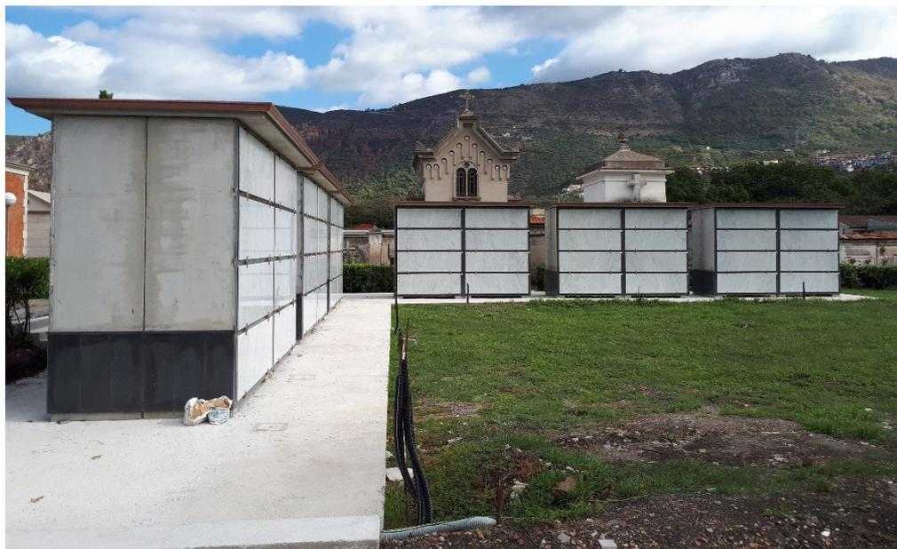
Foto 4 – Loculi di nuova costruzione realizzati da completare con pavimentazione e rivestimenti laterali
